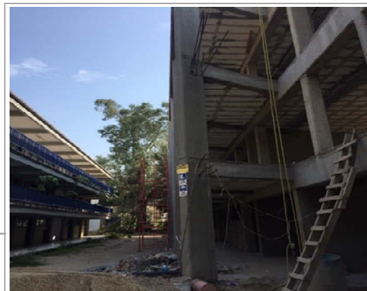
F3: Fachada posterior
