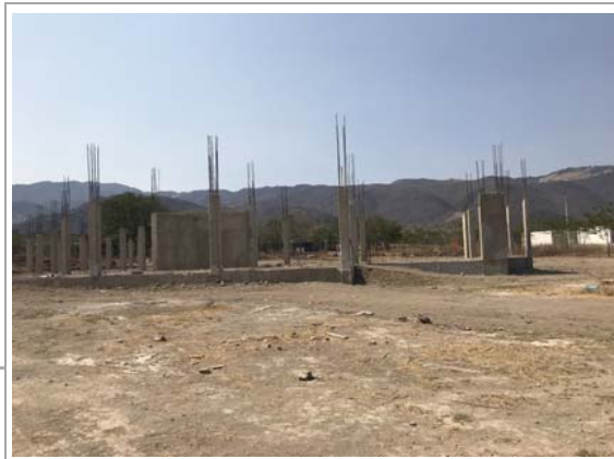
F3: Fachada posterior
