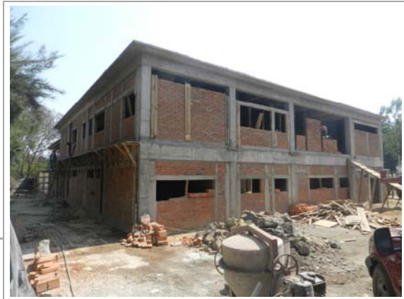
F3: Fachada posterior
