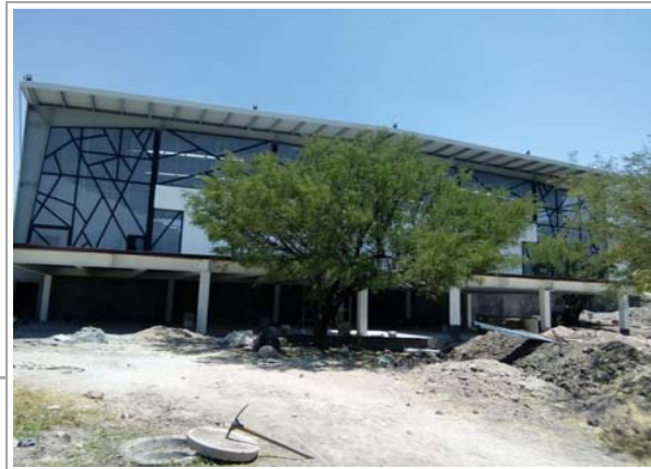
F3: Fachada posterior
